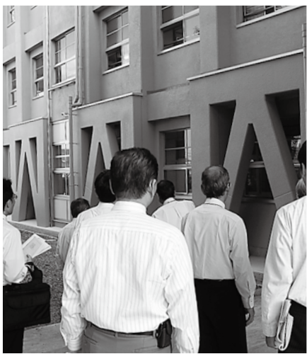
耐震補強された校舎(田辺小学校)
