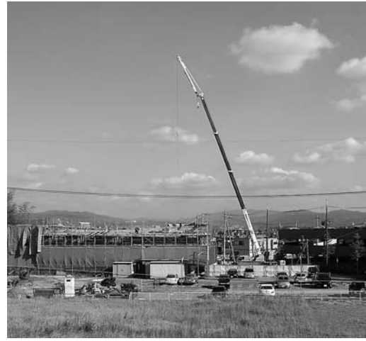
4月に開園予定の松井ヶ丘保育園建設工事
