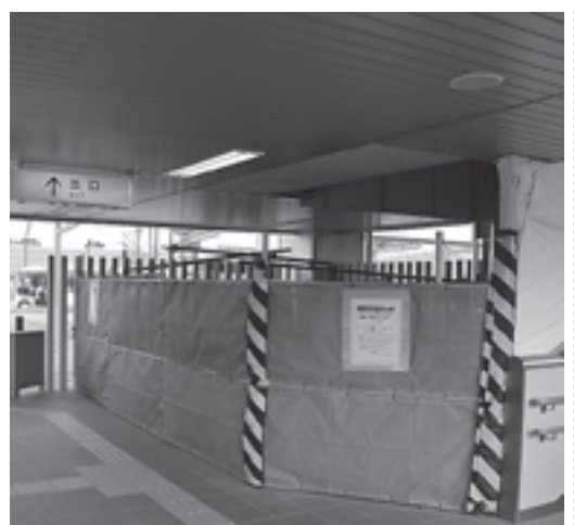
エレベーターが設置されるJR三山木駅
