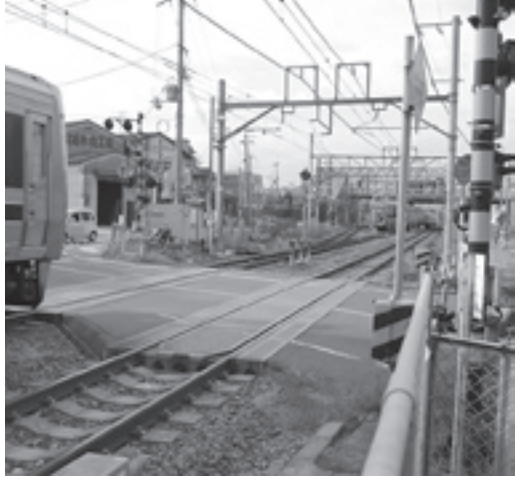
拡幅整備が実施される JR京田辺駅南側の踏切(信楽街道踏切)
