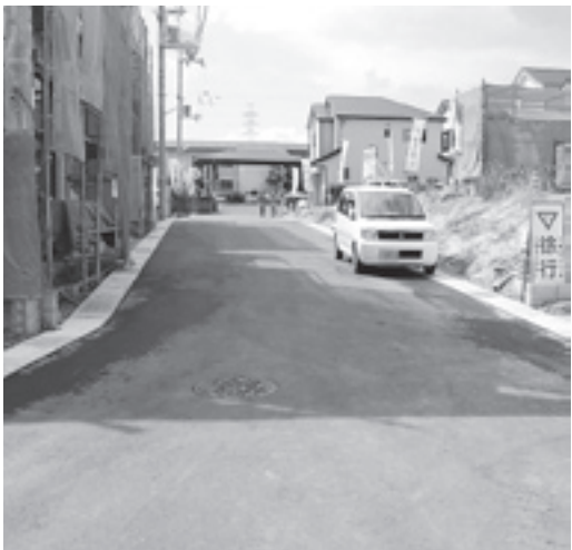
住宅開発に伴い新設された道路(大住)
