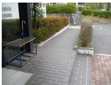
正面出入口横スロープ
