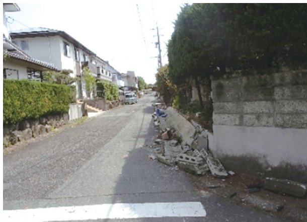
外墙的倒塌（熊本地震）
