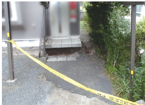
建筑物周边地盘下沉（北海道胆振东部地震）
