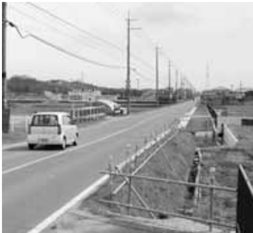
整備が望まれる市道草内三山木線
