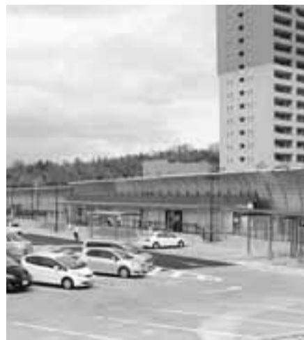
第二京阪道路に開設された京田辺パーキングエリア(松井山手)
