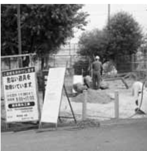
危険遊具の撤去作業が進められている公園
