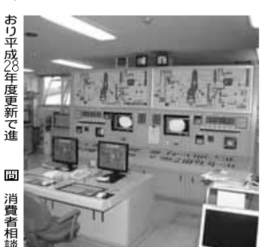
老朽化のため計装システムが更新される甘南備園中央制御室
