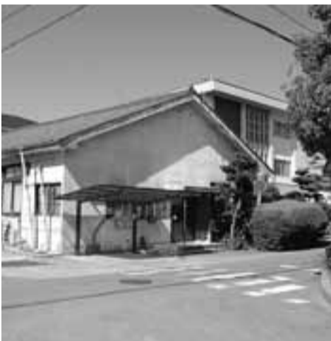
解体される市立福祉センター
