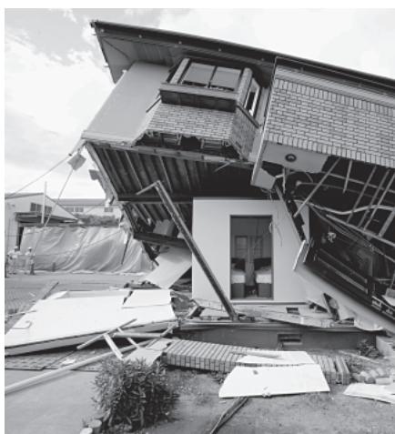
一部屋型シェルターの一例 (写真提供:株式会社一条工務店)
