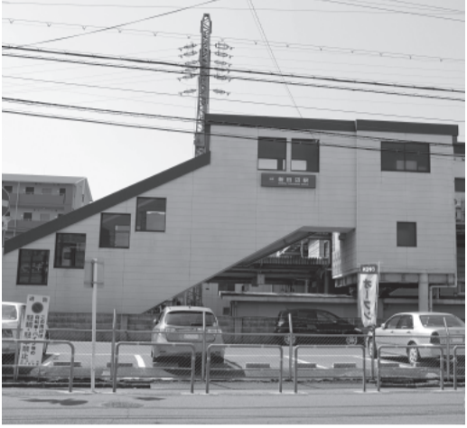
エレベーターが設置される新田辺駅東側
