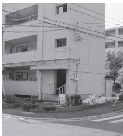
個別ゴミ収集の実施が望まれる高層住宅
