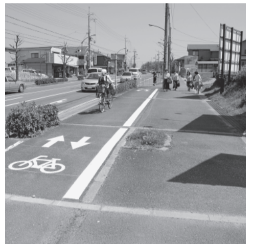
山手幹線沿いに新設された 自転車道(松井ヶ丘地内)
