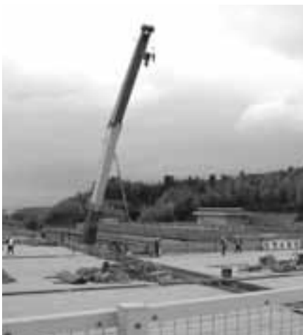
建設が進む第二京阪 田辺パーキングエリア
