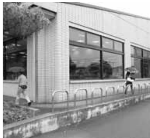
中央図書館玄関から 駐車場へ続く専用通路
