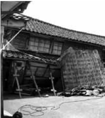
新潟県中越沖地震により倒壊した住宅 (写真提供:新潟県)
