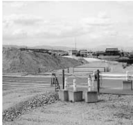
新設される山手幹線と市道の交差点(新)
