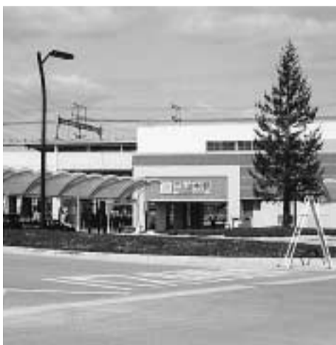
供用開始した三山木駅前広場
