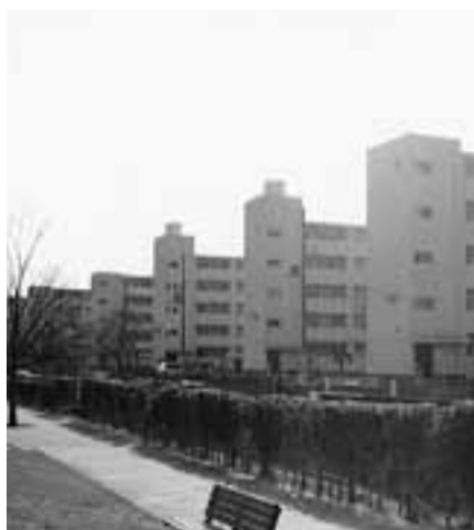
火災があった府営住宅田辺団地(河原神谷)
