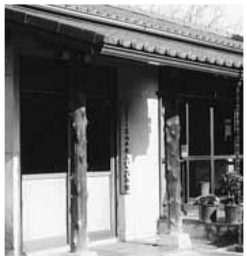
浴室が設置される三山木老人いこいの家
