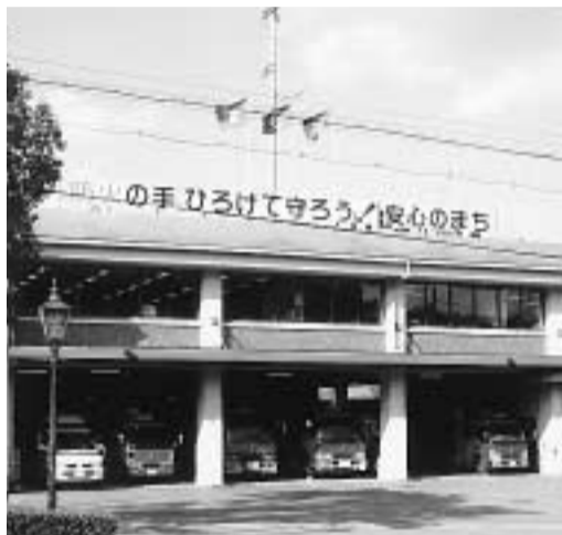
消防活動の中心である消防本部
