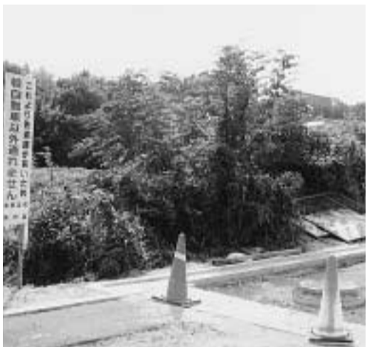
興戸南幹立で開発が進められている現場
