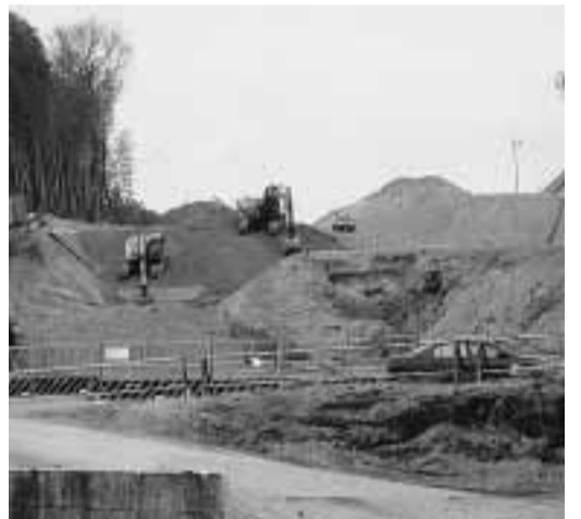
山手幹線の工事が進む(新工区)
