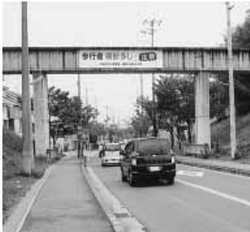
新田辺駅前線の上にある馬坂川の水路橋
