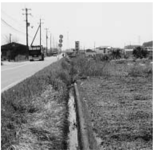
整備計画がある草内地区排水路
