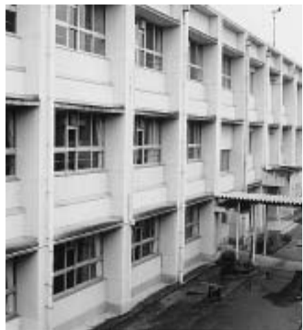
耐震化優先度調査が実施された草内小学校
