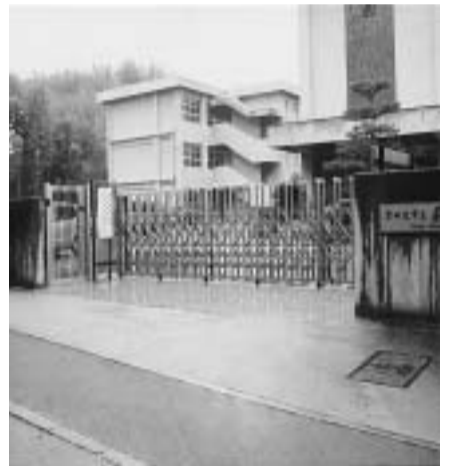
門扉の改修やインターホーンが設置された薪小学校
