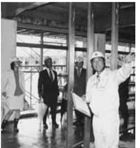
建築中の児童館・老人福祉センター (大住ふれあいセンター) を視察
