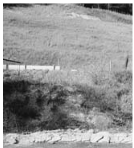
緊急相造成工事が行なわれた急傾斜地(三山木天神山)
