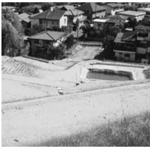
土砂が搬出された急傾斜地(三山木天神山)
