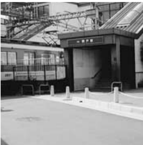
エレベーター設置が予定されている近鉄興戸駅
