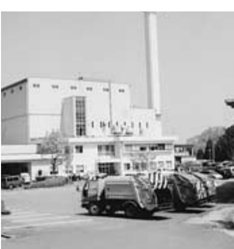
リサイクルプラザ建設が予定されている市甘南備園
