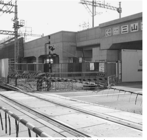
三山木駅の奈良行き高架化工事が進む三山木地区特定土地区画整理事業(3月16日)
