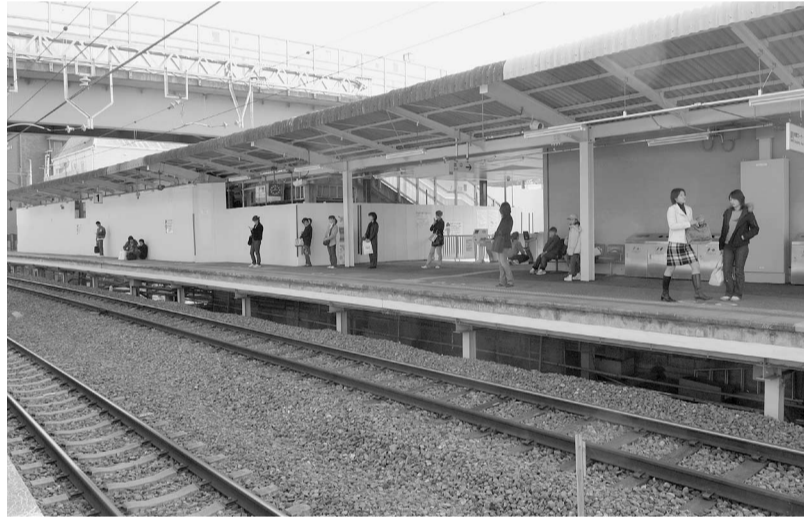
ホームの拡幅工事が進む同志社前駅(3月16日)
