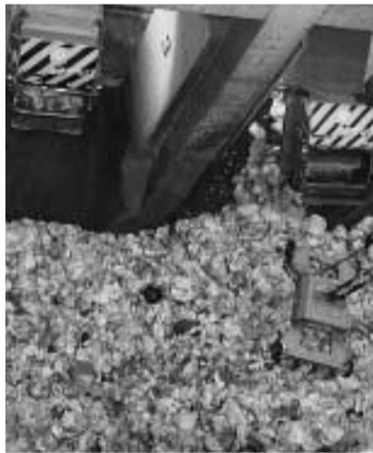
ごみで埋め尽くされた環境衛生センター甘南備園のごみピット
