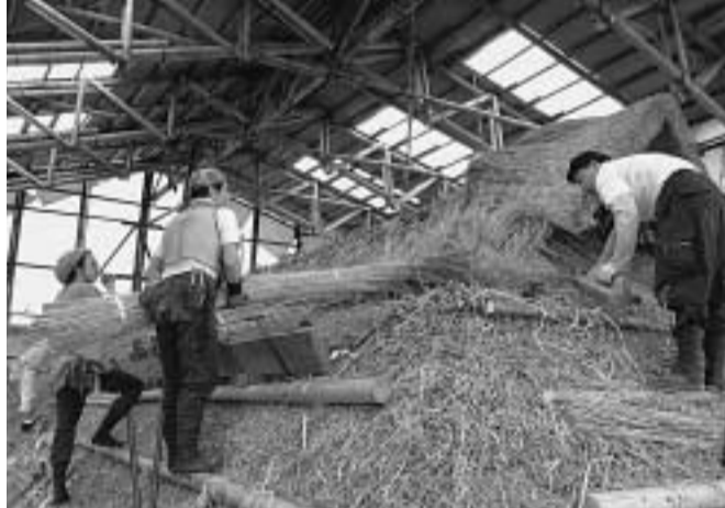
ふき替え作業を行う作業員
