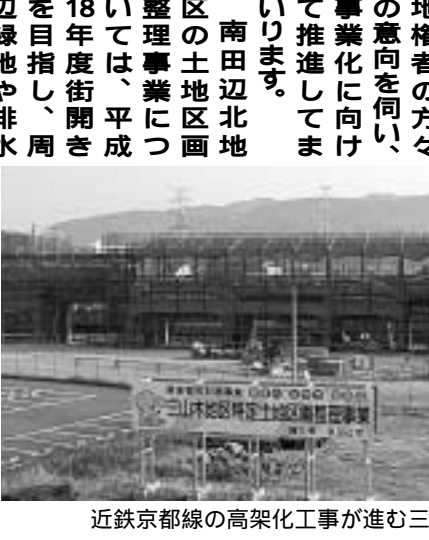
近鉄京都線の高架化工事が進む三山木地区
