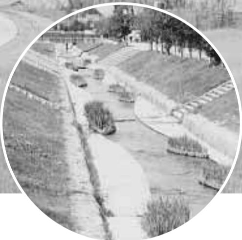
天井川を切り下げてきた防賀川緑道(東地区)
